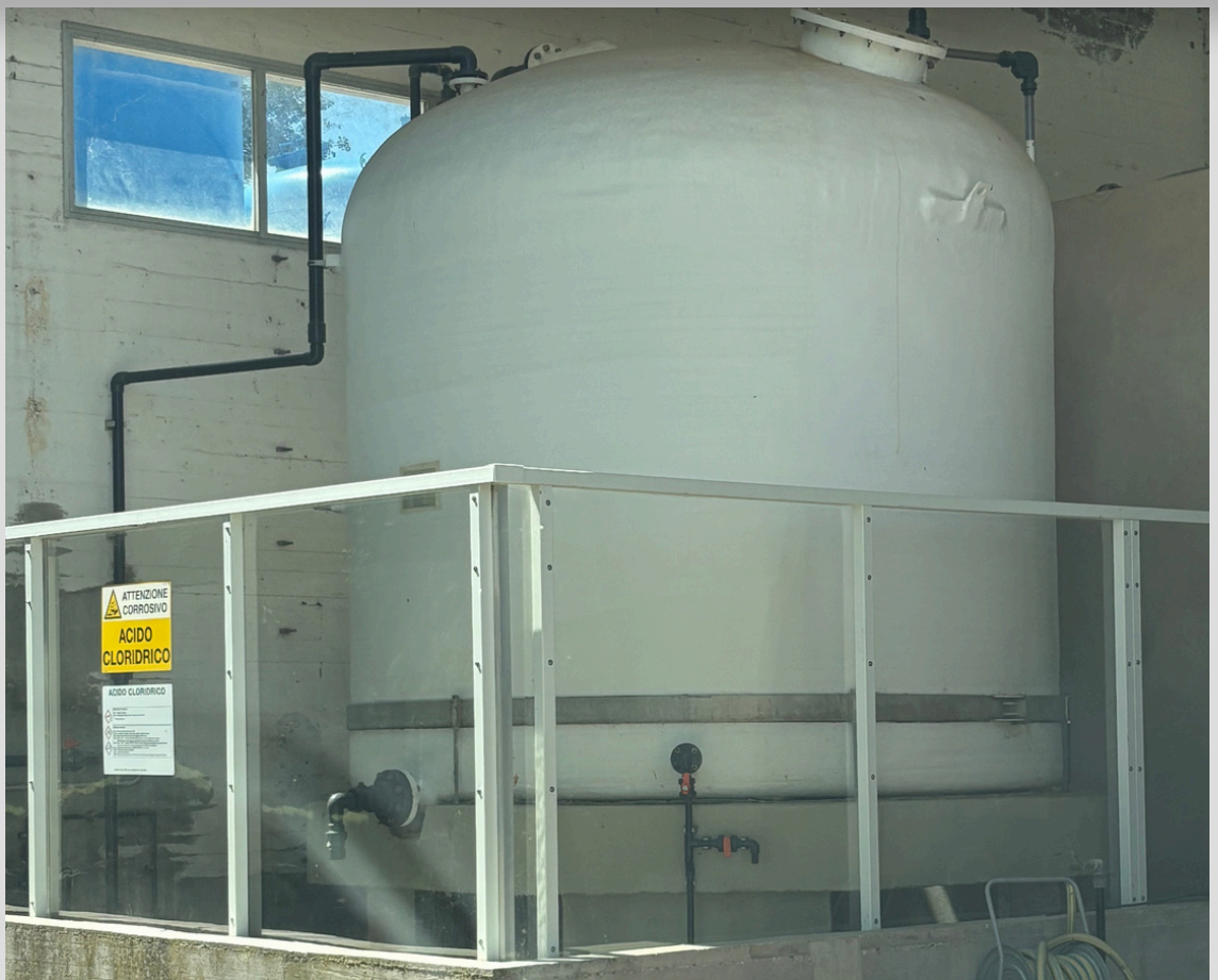
ART.4 20MC DN 3000 PER ACIDO CLORIDRICO
