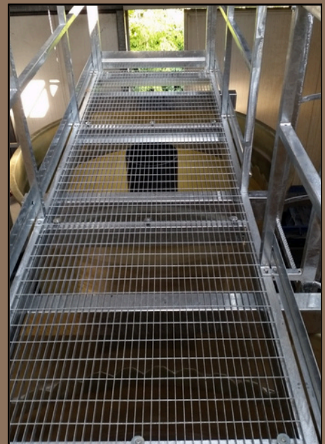
PASSARELLA CON PARAPETTO IN TUBOLARE ZINCATO A CALDO
